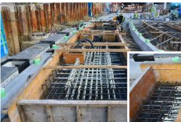
現場打設コンクリート部の配筋状況
