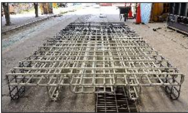
プレキャストコンクリート部の配筋状況 (ComBARの使用)
