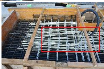
現場打設コンクリート部の配筋状況
