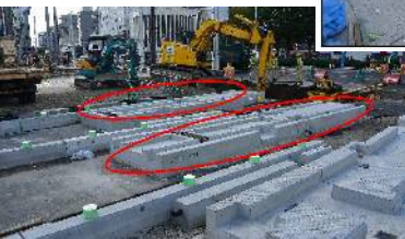
プレキャストコンクリート部の配筋状況 (ComBARの使用)
